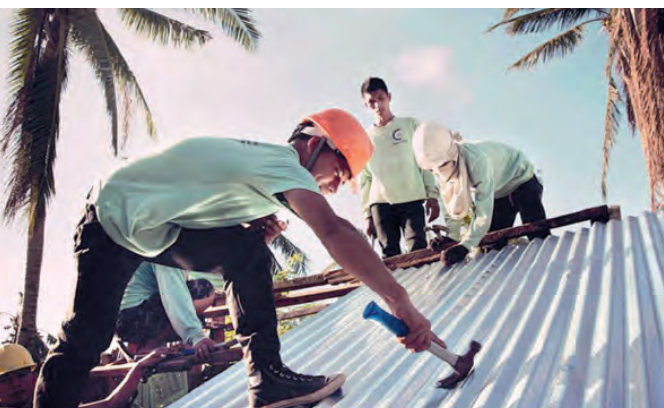
Azubis der Don Bosco-Einrichtungen helfen betroffenen Familien beim Wiederaufbau ihrer Häuser.
